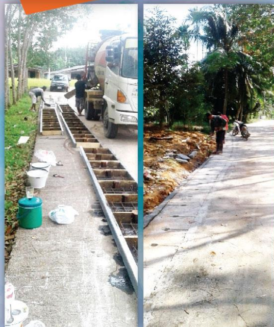
โครงการซ่อมแซมและปรับปรุงคูระบายน้ำคอนกรีต เสริมเหล็กจากศาลาประชุมถึงบ้านนางนัยนา คำเจริญ
