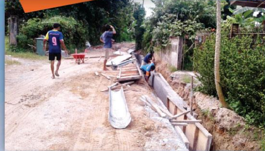
โครงการก่อสร้างคูระบายน้ำ ซอยเทศบาล 10
